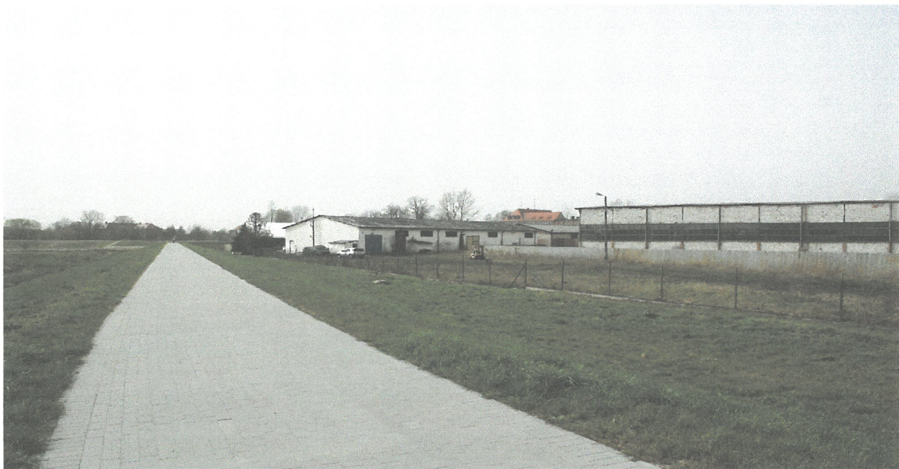
Widok hali od strony południowo-wschodniej (od ulicy Pocztovej)
